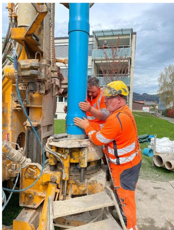
mit den Grundwasser Bohrungen. In einer Tiefe von 26 Meter entnehmen wir das nötige Grundwasser. Nach dem Durchlauf durch unsere Wärmepumpen wird das Wasser um 3 Grad abgekühlt, dem Grundwasser in einem separaten Rückgabeburrunnen, ebenfalls 26 Meter tief, wieder zurückgegeben. Die Brunnen sind so berechnet, dass in einem späteren Zeitpunkt auch die Gebäude 9 und 11 versorgt werden könnten. Wie fast immer bei so komplexen Bauwerken hat sich die Bauzeit um einige Wochen verlängert.
